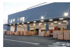
②自社自動倉庫外観
