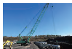
①土木工事現場の風景
