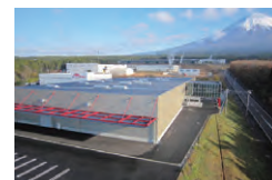
②工場外観
