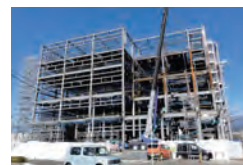
②工事現場
