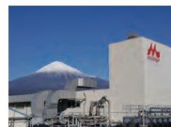
① 工場外観
