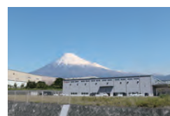
①新工場の外観
