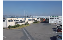
②工場外観写真
