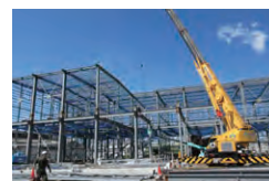
②建築工事現場の風景
