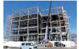
②工事現場
