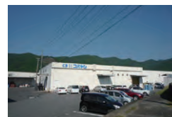
①工場外観
